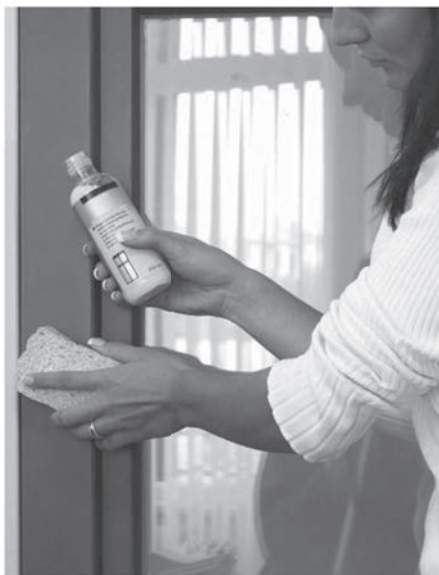
konzervace ploch pomocí dodaného mléka
